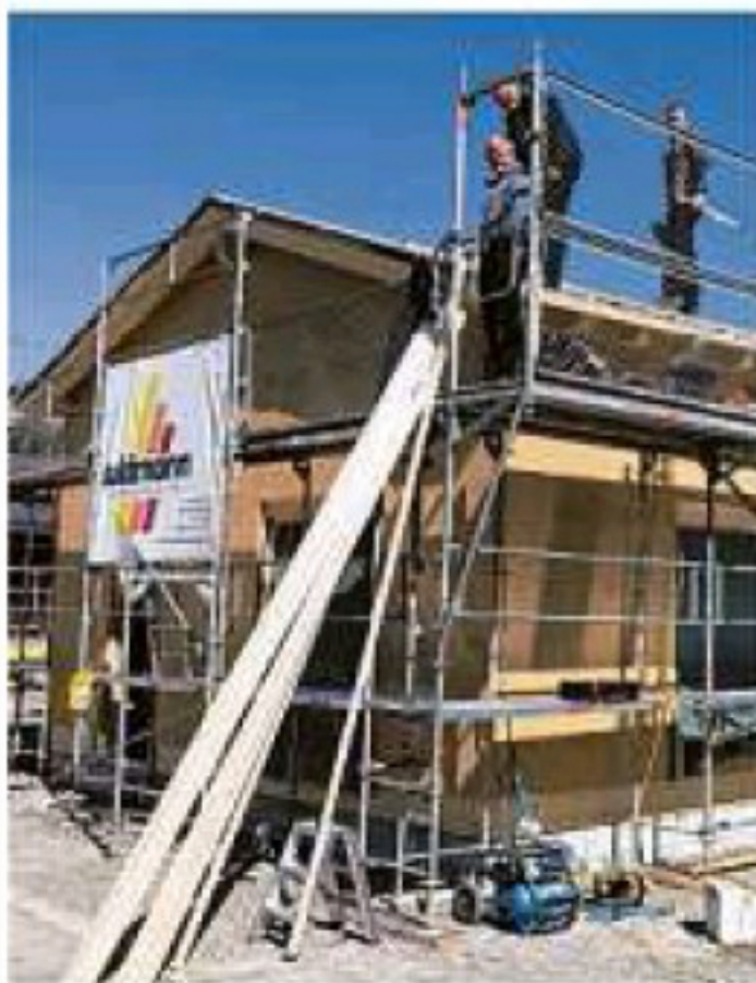
Der Rohbau ist fertig, ein Richtfest gibt es jedoch nicht.
